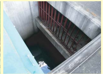
スクリーン装置は、用水路に流れてきたゴミを取り除く施設です。
