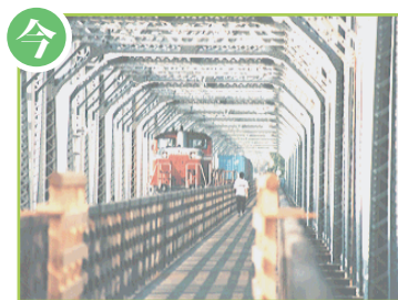
城東貨物線赤川鉄橋
