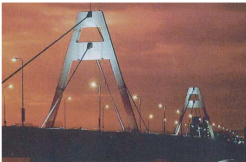
■豊里大橋の力強いライトアップ
