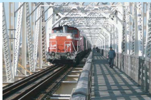
■ 通称「赤川鉄橋」
